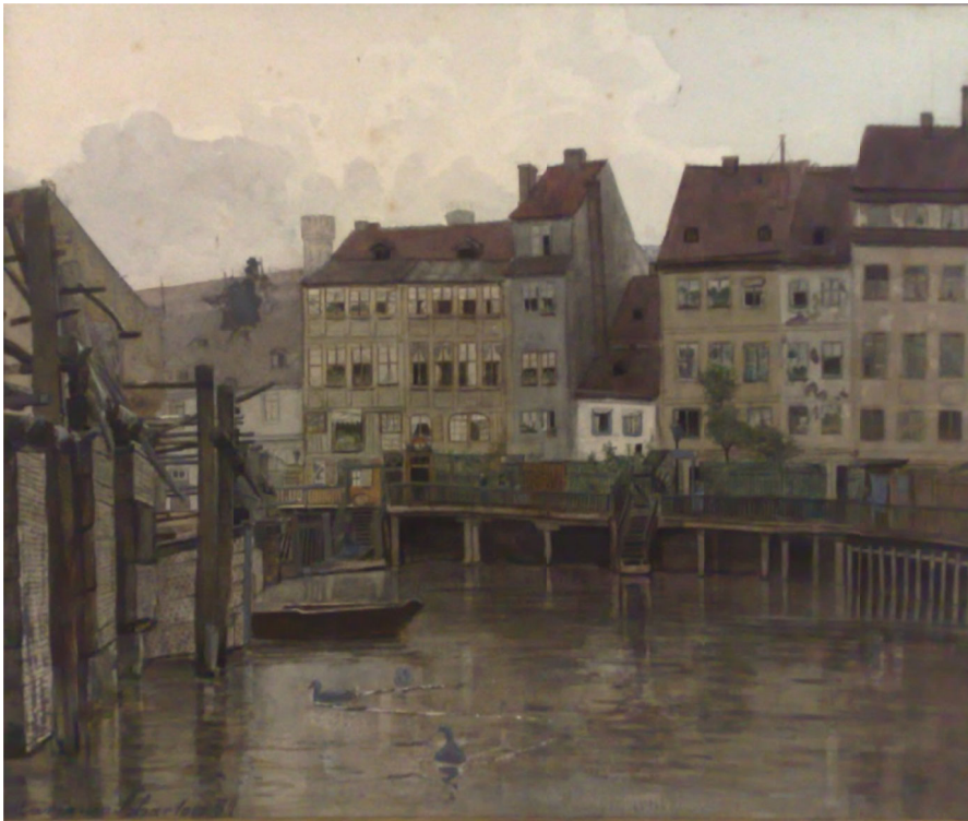
Häuser am Wasser (Berliner Ansicht)
